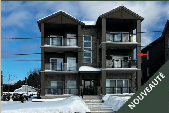
Superbe condominium 4½ avec vue sur le Lac Archambault. Construction 2021. Belle possibilité de location à court et long terme. 399 000 $ - MLS26976158
