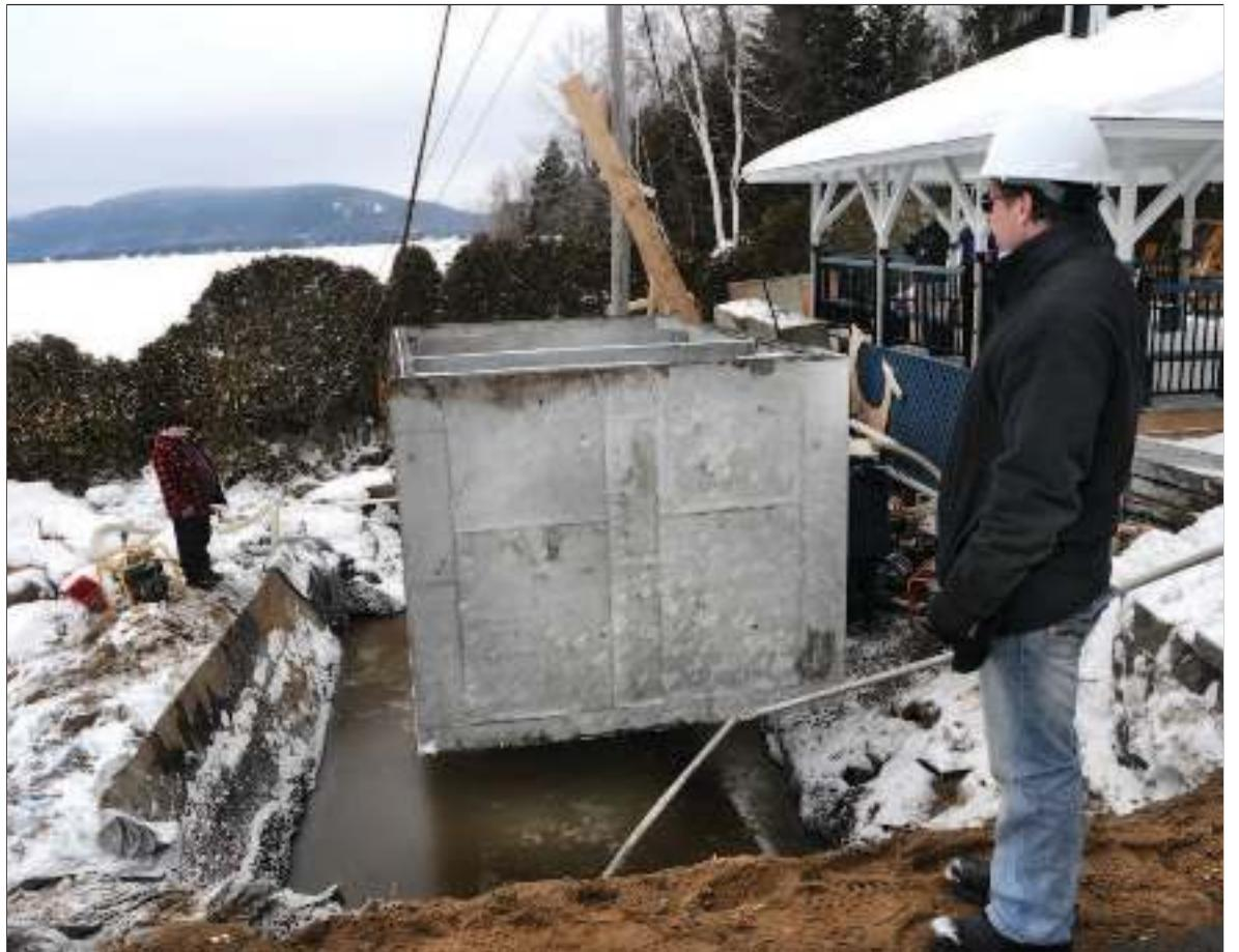
Photo du haut: le capteur à sédiments lors de son installation en bordure du lac Archambault. Ci-contre: photo 3D de l'intérieur et du fonctionnement du capteur.
