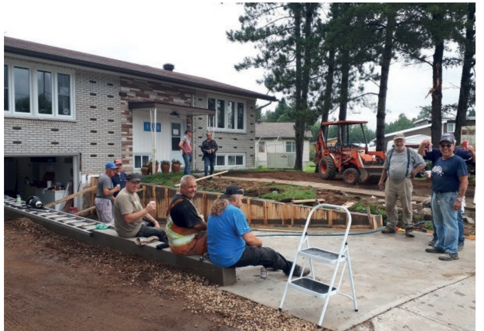
En été 2023 Normand Forget et son groupe de valeureux bénévoles mettent la main à la pâte afin de réparer, rénover et rendre accessible le garage et le sous-sol de l'établissement toujours dans le but de répondre aux besoins grandissants de la communauté. (Photo gracieuseté)
