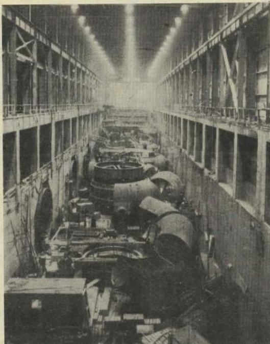
A l'intérieur de la centrale de LG 4, le turbiniériste, Marine Industrie Ltée, s'affaire à l'assemblage d'un casse-tête géant constitué des baches spirales et des turbines qui formeront la base des neuf groupes générateurs.
