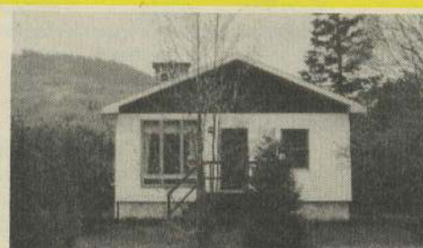
FACE MONT LA RÉSERVE: cottage, 2 c.c., foyer pierre des champs. Terrain: 26772 pi. ca. Excellente occasion. 57 000$
