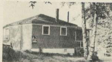
VUE PANORAMIQUE, SPORTS SANS LIMITE! Au lac Blanc, chalet d'été, 2 chambres à coucher, directement sur le lac, 86 pieds de bord de l'eau, exposition sud, pied du Mont Garceau. Pour les adeptes de plein air! Seulement 48 500$! Jean Lavoie.
