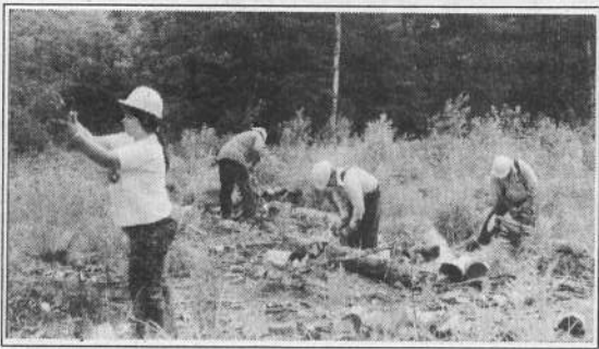
On est déjà à l'oeuvre pour ouvrir la nouvelle piste.
