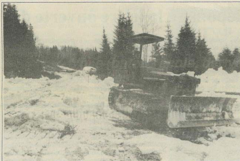
Très tôt à la fonte des neiges, on a commencé à déblayer l'accès à la montagne.
