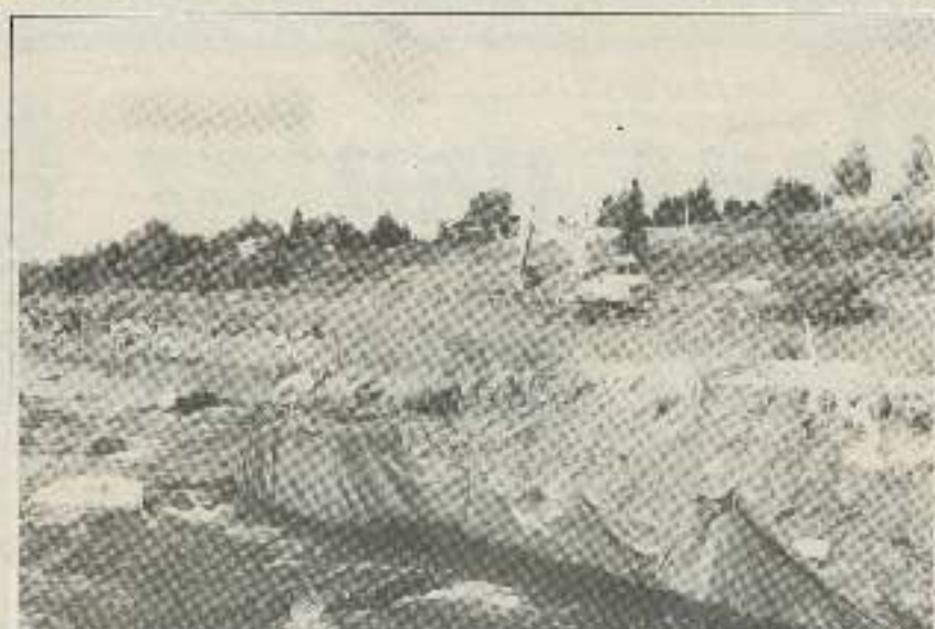
On voit ici la dérivation des eaux de la rivière pour permettre le creusement du bassin et la construction éventuelle du barrage de rétention d'eau.
