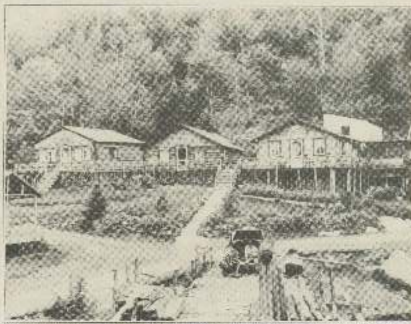
Cette photo fut prise en 1951 et montre les installations du Club Caribou. Le camp de droite est le premier à être construit durant l'été 1932.
