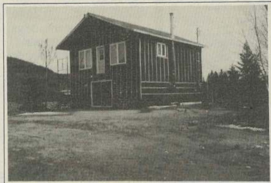
Une bonne ventilation règle les petits problèmes de condensation et d'humidité.
