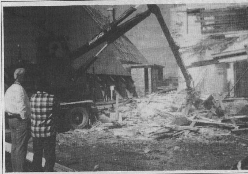
Sans émoi, sans reproche, à peine quelques gens assistaient à la démolition de 72 ans d'histoire religieuse et sociale. Au cours de son règne, ce presbytère avait accueilli 10 curés.
