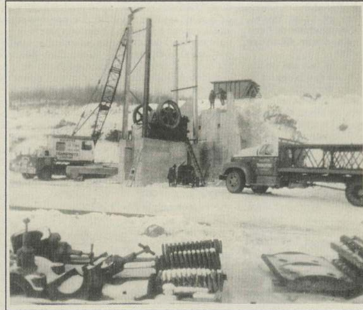
En 1956-57, on entreprend la construction du "Primaire". La grue et le camion appartiennent à Sciotte Transport. Cette machine munie de deux grosses roues à air fonctionne à l'aide d'un moteur électrique de 150 forces. Pierre Parent, un machiniste de Sainte-Agathe, était chargé des travaux d'entretien.
