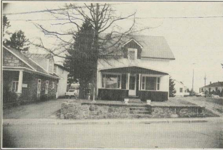
Art Boréal a maintenant pignon sur rue, à Saint-Donat.
