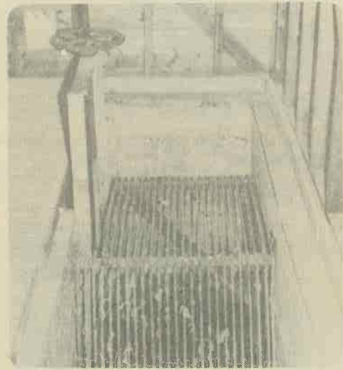
Un système de barres de fer retient les résidus comme papier ou morceaux de bois, Tous les matins, un employé municipal doit nettoyer cette partie.
