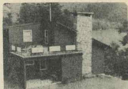
Lac Archambault: Chalet hivernisé. Extérieur en semi-log. Salon avec foyer en pierres. 3 chambres à coucher, cuisine, 2 salles de bain, sauna, salle de lavage, tapis mur à mur, chauffage électrique. Vue magnifique.
