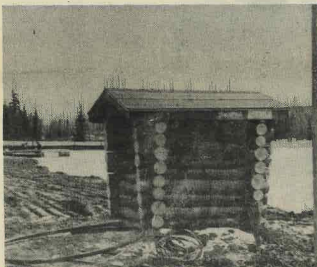
Abri des compresseurs.
