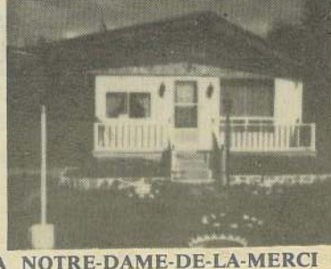
A NOTRE-DAME-DE-LA-MERCI - rang 6 Ouest Chalet hiver-été, meublé, avec garage et abri-auto. Cuisine - salon - 3ch. à coucher - Salle de bain complète. Syst. de chauffage central à air chaud - réservoir à eau chaude. Prix $16,000.
