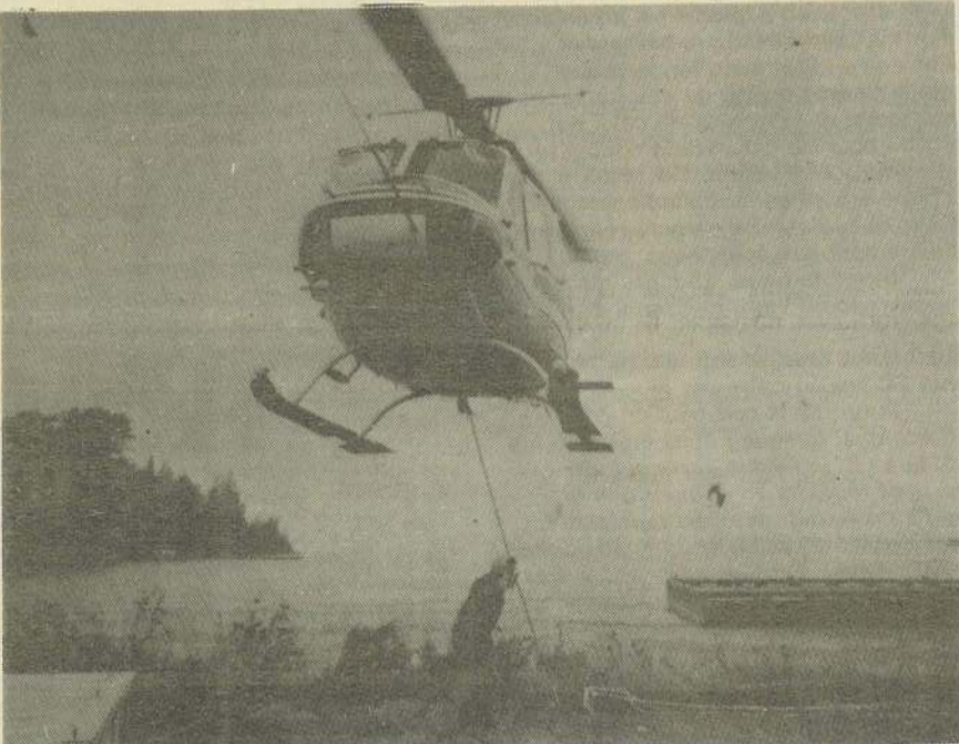
L'opération accrochage : il ne s'agit pas qu'à mi chemin le poteau se détache.
