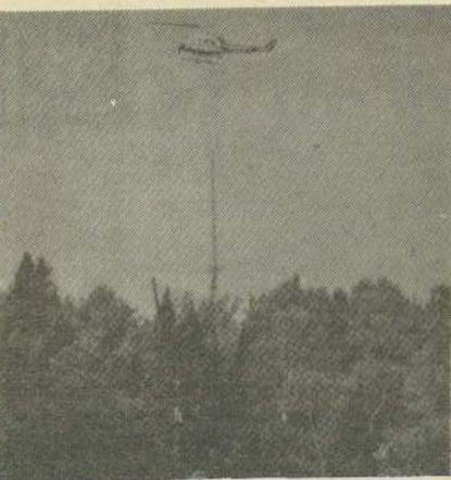
Avec la précision d'un horloger, le pilote va déposer son encombrant colis dans un trou d'environ 1 m de diamètre.
